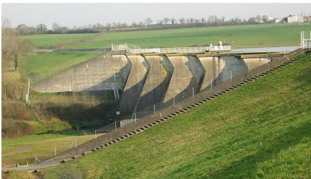
Barrage du Verdon (2023)
