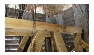
L'entreprise Bodet campaniste, de Trémentines, était en charge du chantier de rénovation du beffroi, à savoir la charpente et le plancher. L'existant était « en mauvais état, s'affaissait, appuyait sur la pierre alors qu'il ne faut pas et les poutres d'assises soient défectueuses », détaillait Christophe Binet de l'entreprise Bodet.
