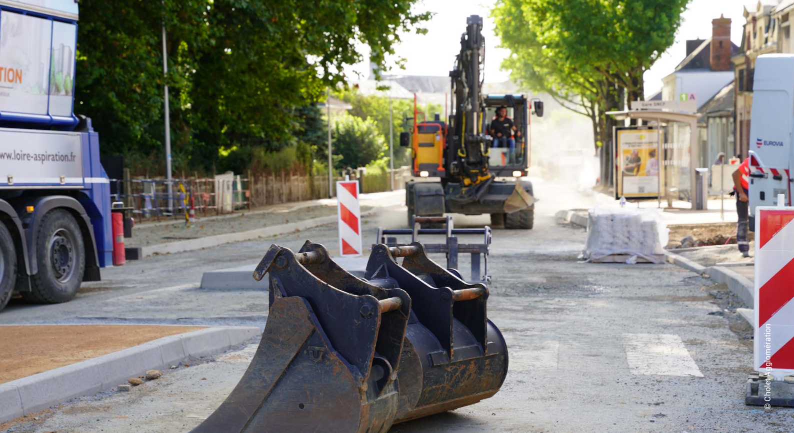
Travaux boulevard Jeanne-d'Arc (Cholet)
