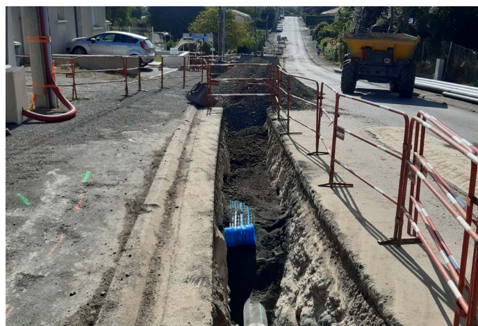
Chantier eau potable à La Romagne
