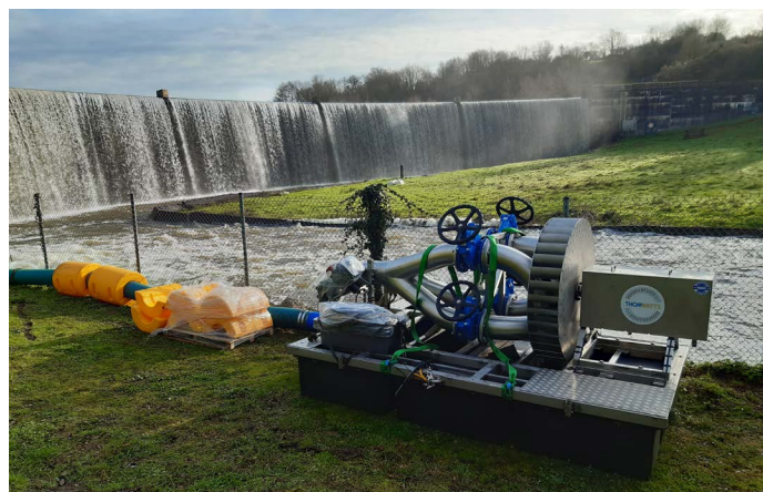
Mise en service d'une micro-turbine sur le débit de restitution du barrage de Ribou
