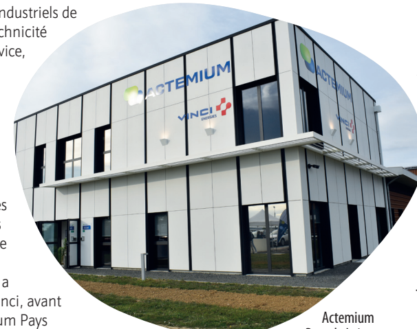
Actemium Pays de Loire automation a inauguré son bâtiment neuf, fin septembre.
