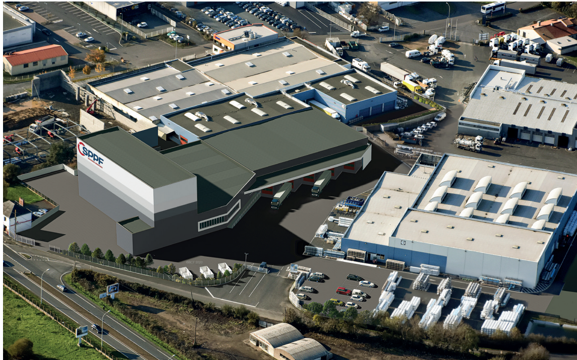
L'entreprise SPPF, avec, à gauche, le transstockeur de 22 m de haut, dont la construction débutée fin 2022 s'est achevée fin 2023.
