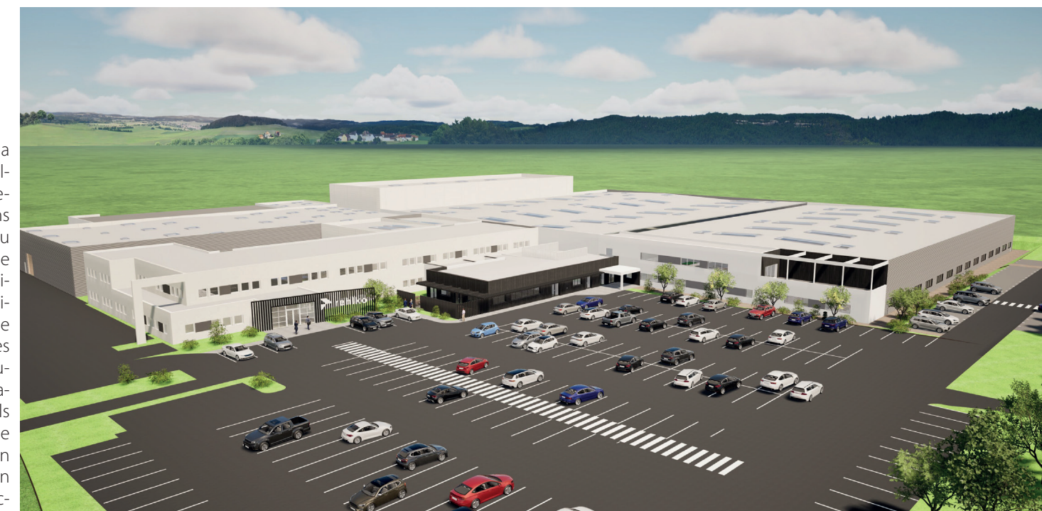
Déjà agrandi à quatre reprises, la dernière fois en 2023, le bâtiment de Rehlko connaît un nouveau projet d'extension de 5 000 m 2 que l'on se représente aisément entre la vue du ciel actuelle (photo du haut) et la modélisation du projet (visuel ci-dessus).
